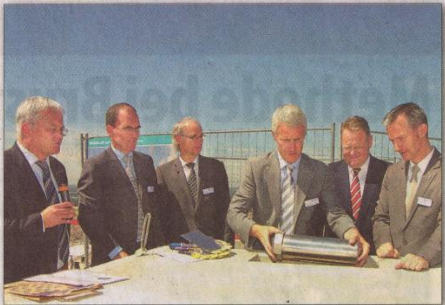
Bestückt mit Zeitdokumenten wird eine Info-Bombe von allen Akteuren in das Fundament eingelassen.
