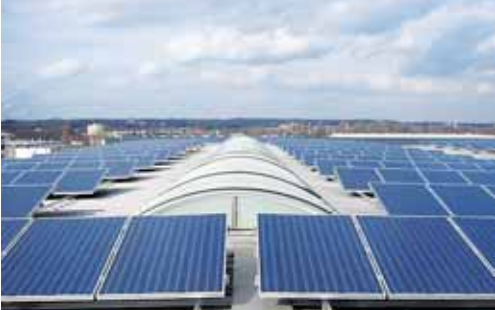
Das Logistikunternehmen LOXX GmbH nutzte die Erweiterung seines Gelsenkirchener Logistikzentrums auf insgesamt 10.000 Quadratmeter für einen umfassenden Umweltschutz – und installierte eine Solaranlage mit 360 kWp Leistung.
