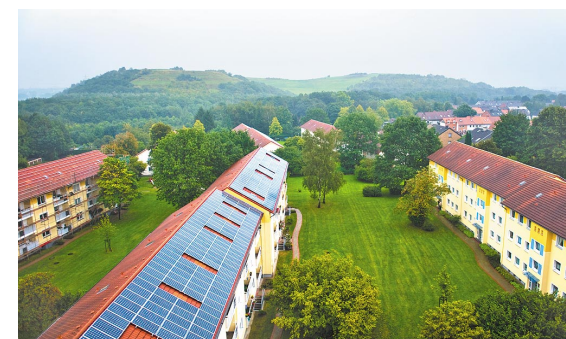
Solarsiedlung Gelsenkirchen-Schaffrath (im Aufbau) Bild: THS / Matthias Duschner
